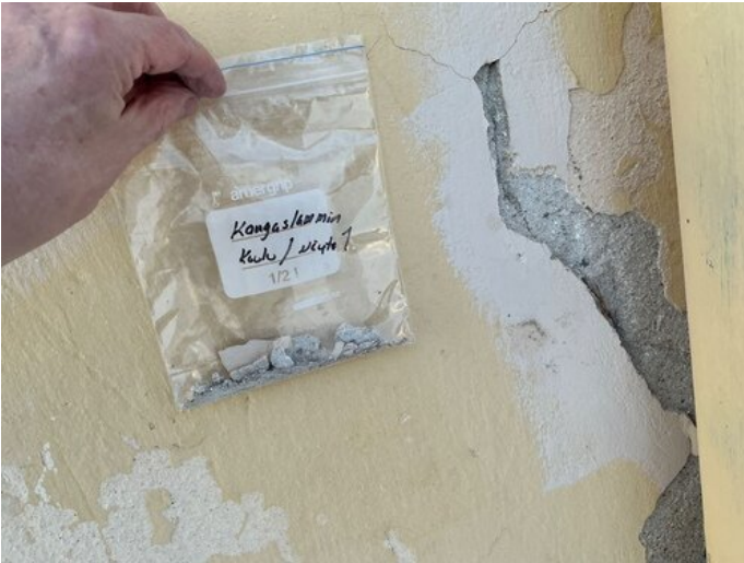
Kuva 1 Näytteenotto kohta ulkoseinässä
