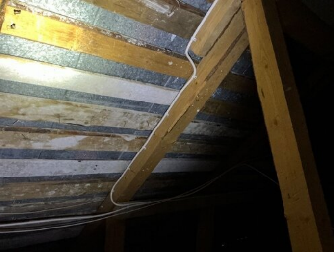
Kuva 5 Kylmän, rakentamattoman ullakon katto
