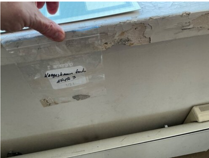
Kuva 3 Näytteenotto kohta salin ikkunapenkissä
