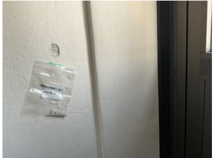
Kuva 2 Näytteenotto kohta tuulikaapin seinässä
