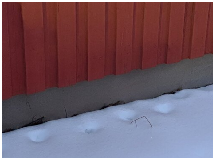
Kuva 4 Kivijalka pinnoittamaton
