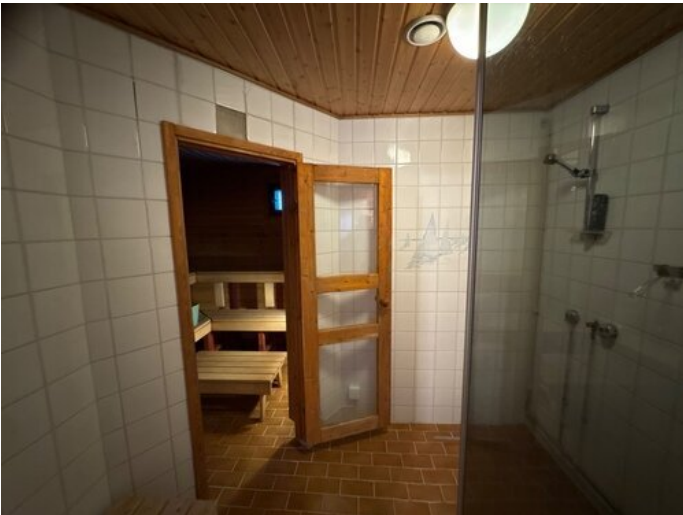
Kuva 7 Yleiskuva kylpyhuoneen pinnoitteista
