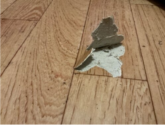
Kuva 5 Näytteenotto kohta tuulikaapin lattiassa. Jokaisessa asuinhuoneessa sama lattiapinnoite
