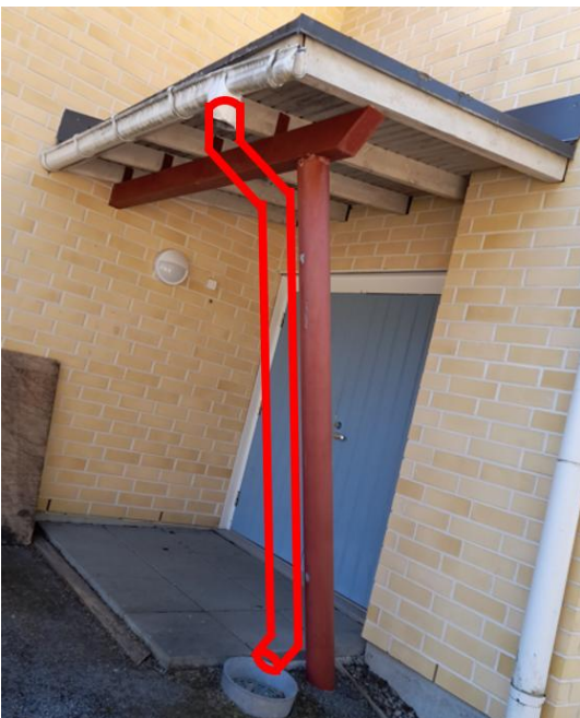
Kuva: uusi syöksytorvi
