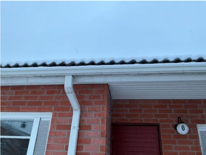
Kuva 1 Vesikatteena betonikattotiili
