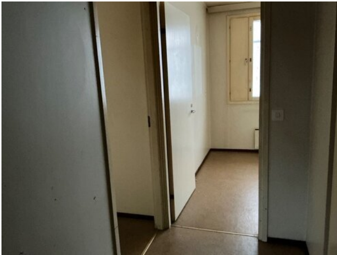
Kuva 5 Asuinhuoneitten seinissä ja katoissa maalattu kipsilevy.
