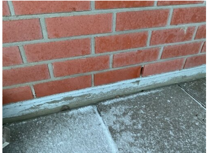
Kuva 2 Sokkeli pinnoittamaton betonisokkeli
