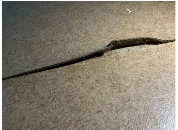
Kuva 4 Asuinhuoneitten alkuperäinen lattiapinnoite on huopapohjamatto, matto liimoineen ei sisällä asbestia
