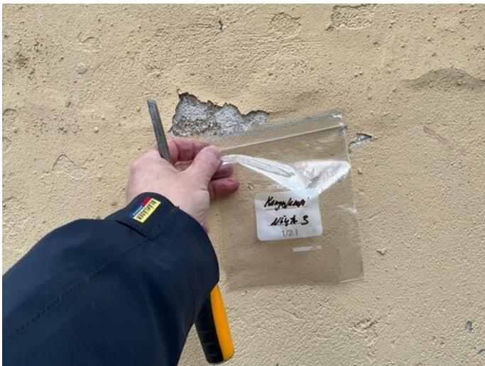
Kuva 3 Näyte 3, näytteenottoa ulkoseinässä
