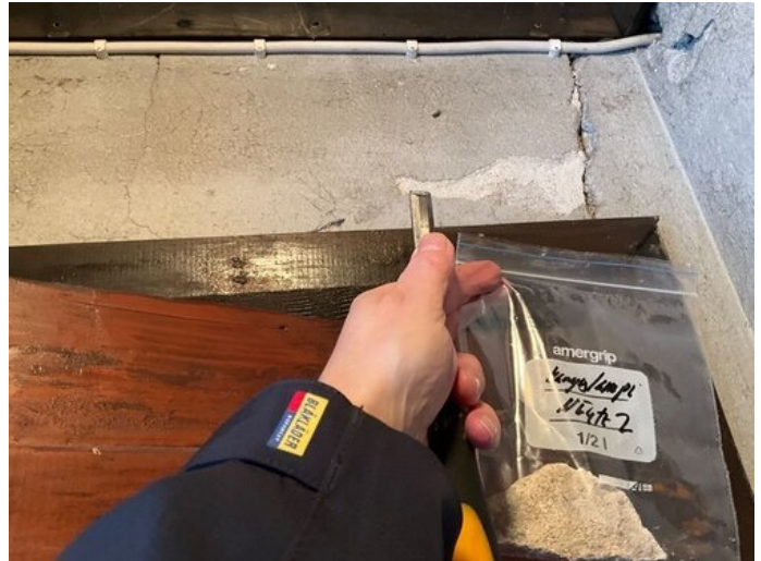
Kuva 2 Näytteen 2 näytteenottoa eteisen seinässä
