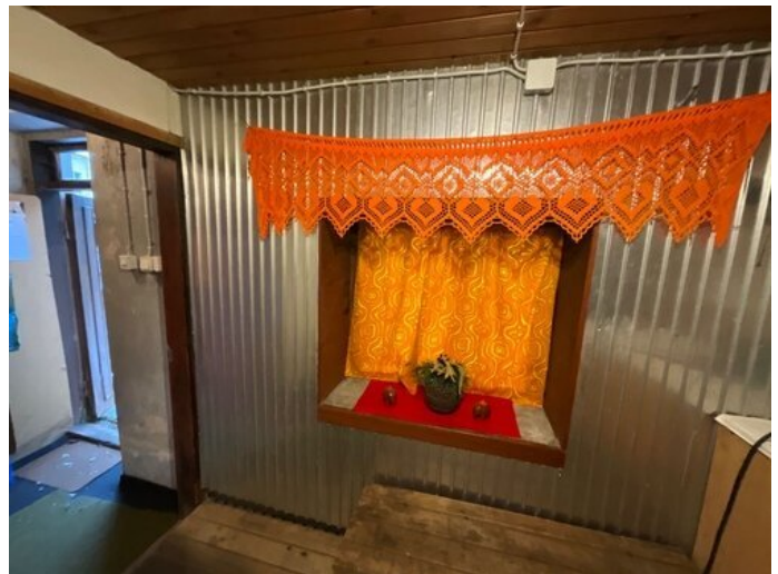
Kuva 4 Seinien pintamateriaaleja, naisten pukuhuone
