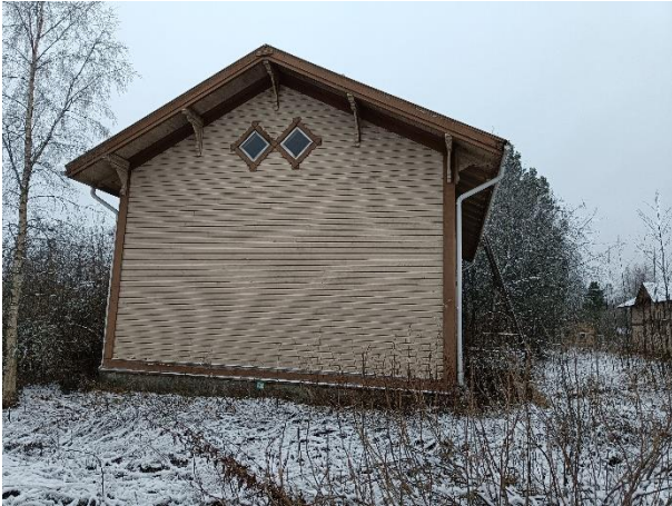
Asuinrakennuksen pääty. Oikealla kellari.
